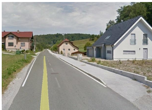
Slika 1: Začetek kolesarske poti, za železniškim prehodom Štrihovec.
