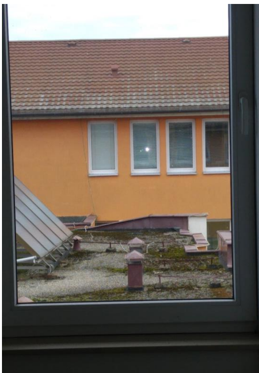
Slika 4: Pogled na streho vmesnega trakta in zahodne strani
