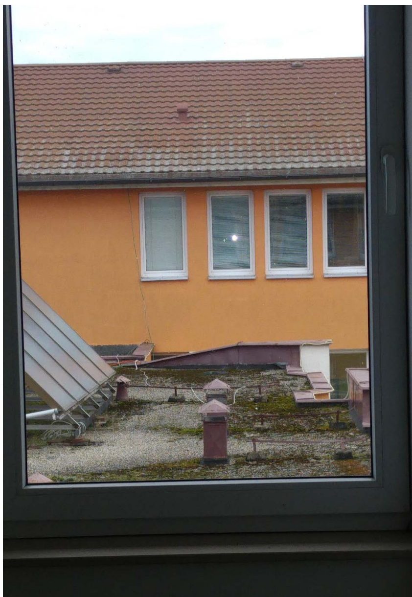
Slika 3: pogled na streho vmesnega trakta in zahodne strani 4
