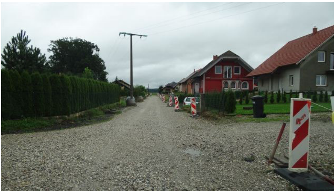
- Slika 3: Izgradnja primarne sanitarne kanalizacije v naselju Radehova
