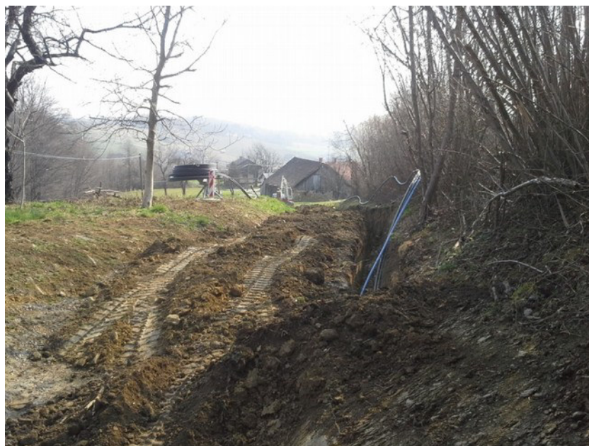
- Slika 5: Izgradnja vodooskrbnega omrežja za območje KS Voličina
