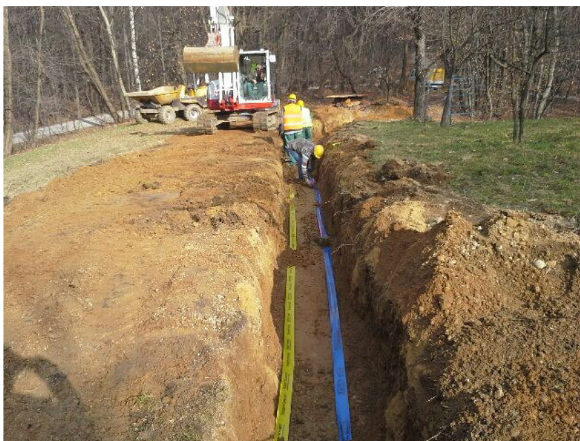
- Slika 6: Izgradnja vodooskrbnega omrežja za območje KS Voličina
