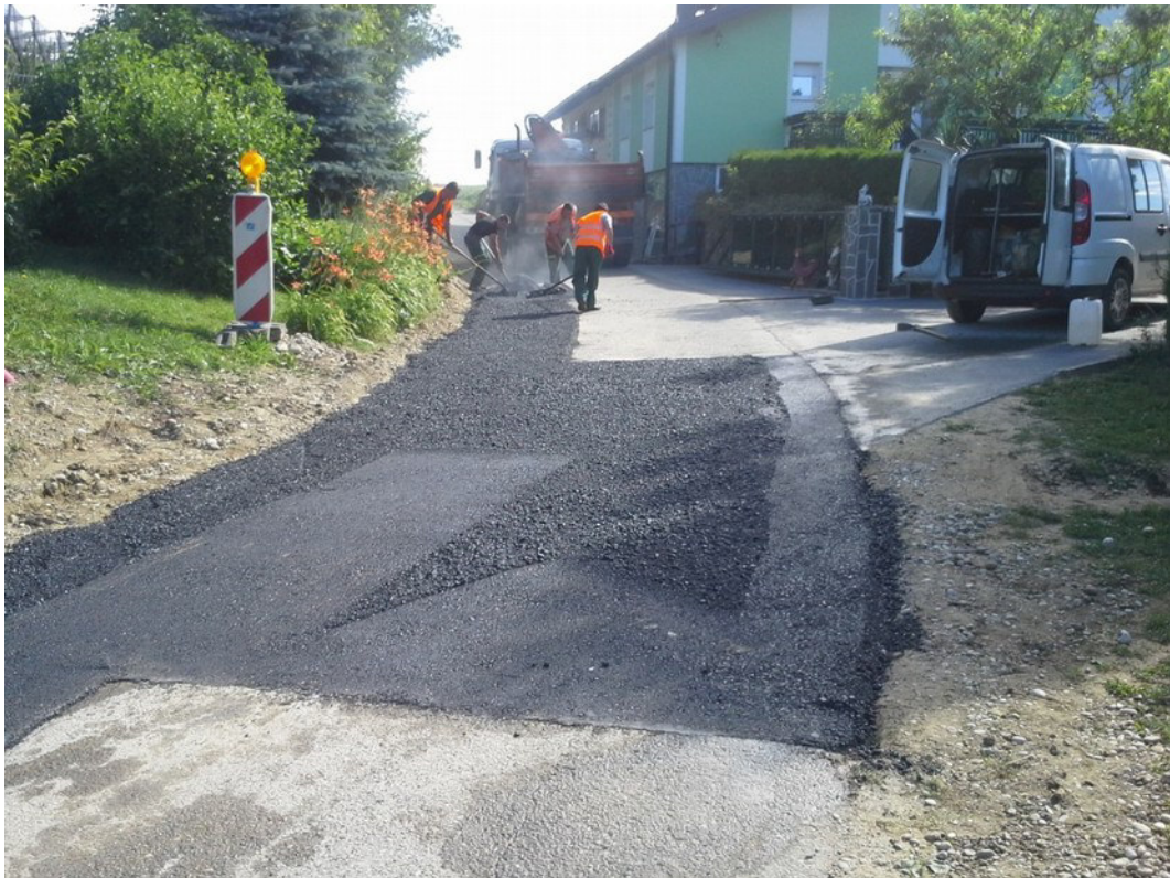
- Slika 7: Izgradnja vodooskrbnega omrežja za območje KS Voličina
