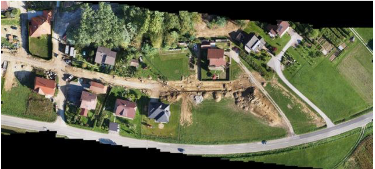
- Slika 4: Izgradnja primarne sanitarne kanalizacije v naselju Radehova
