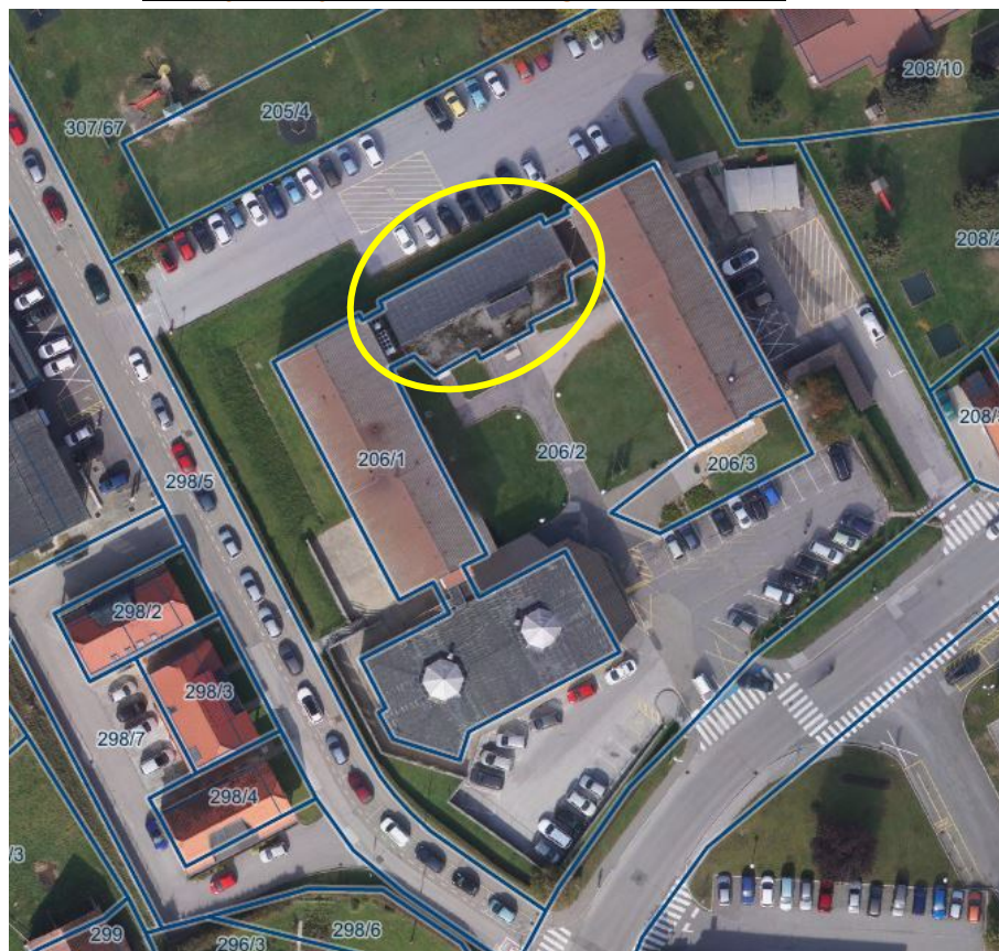
Slika 10: Obstoječi objekt Zdravstvenega doma Lenart
