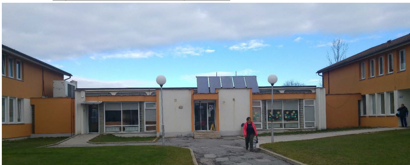
Slika 11: Pogled na vhod v vmesni trakt iz južne strani
