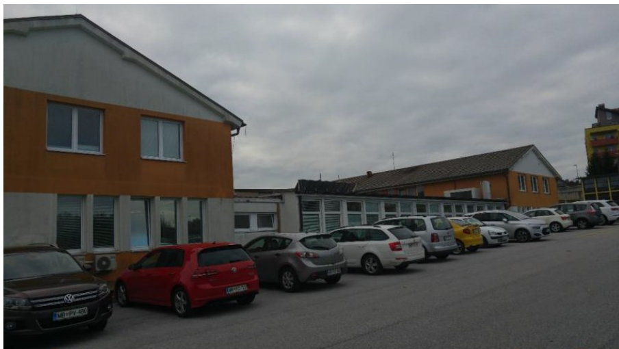
Slika 12: Pogled na objekte iz severne strani
