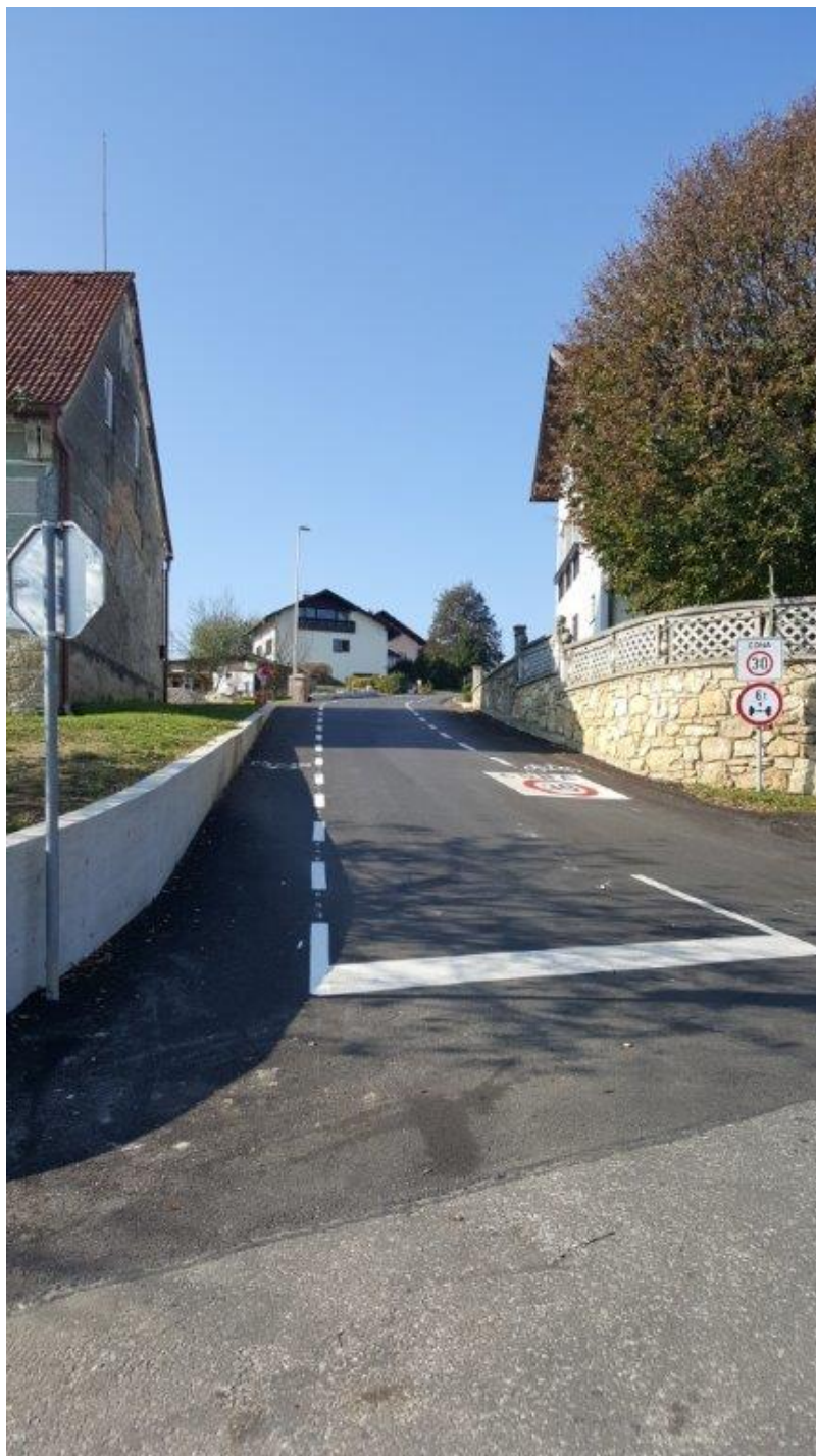
Slika 35 - Sanacija kanaliz. Priključkov / Voličina
