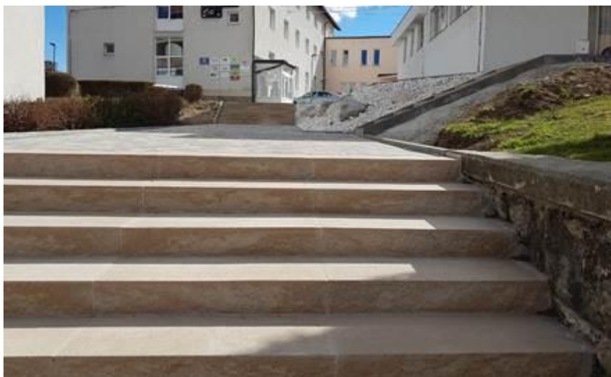
Slika 34 - Ureditev stopnic in ploščadi na Kraigherjevi ul. 2
