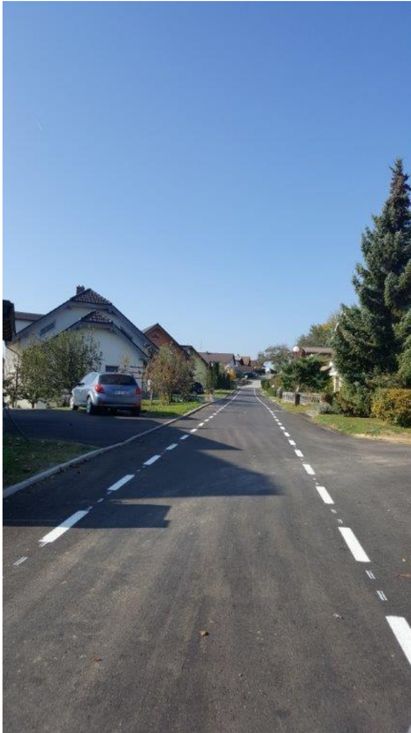
Slika 28 - Nadgradnja kanalizacijski priključkov Voličina
