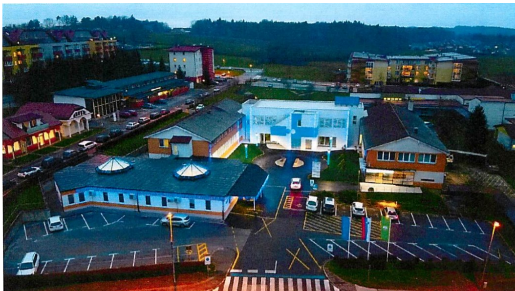
Slika 7: Slika Objekt Zdravstvenega doma Lenart – sedež zavoda
