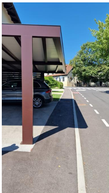
Postavljen nadstrešek v nasprotju z izdanim soglasjem
