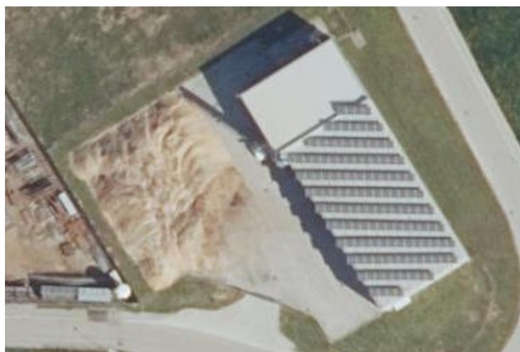
Slika 6: Obstoječi sončni paneli nameščeni na strehi kotlovnice za SDO Lenart
